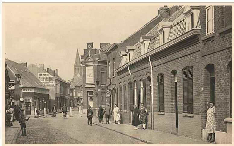
Le poste de douane du Cuirassier vu de France
